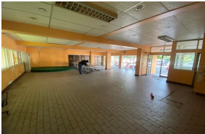
ภาพที่ 3.6 ภาพถ่ายการสำรวจพื้นที่ภายในอาคาร
