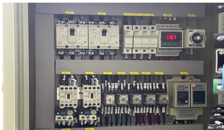
ภาพที่ 3.7 ภาพถ่ายการสำรวจตรวจสอบระบบไฟฟ้าของอาคาร
